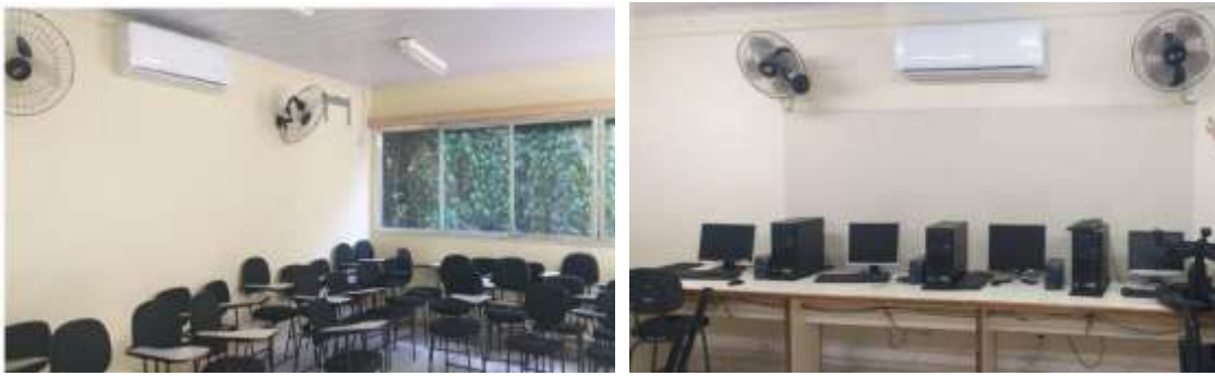
Figura 4- Instalação de Ar-condicionado nas salas novas
