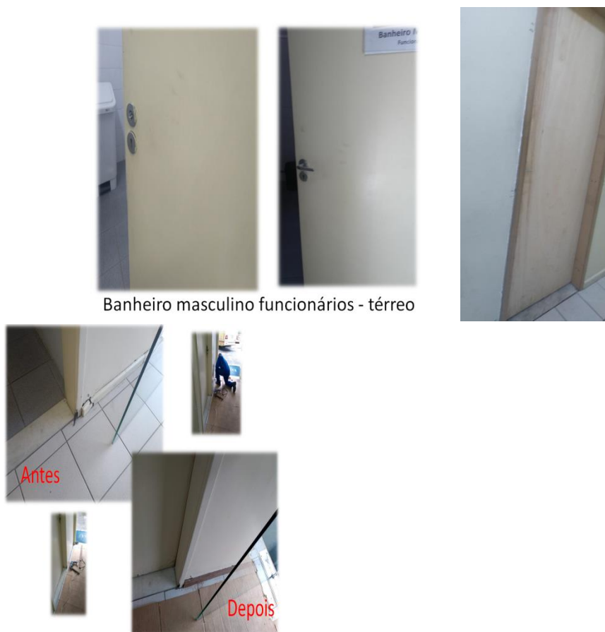
Figura 4 – Reparos no Departamento
