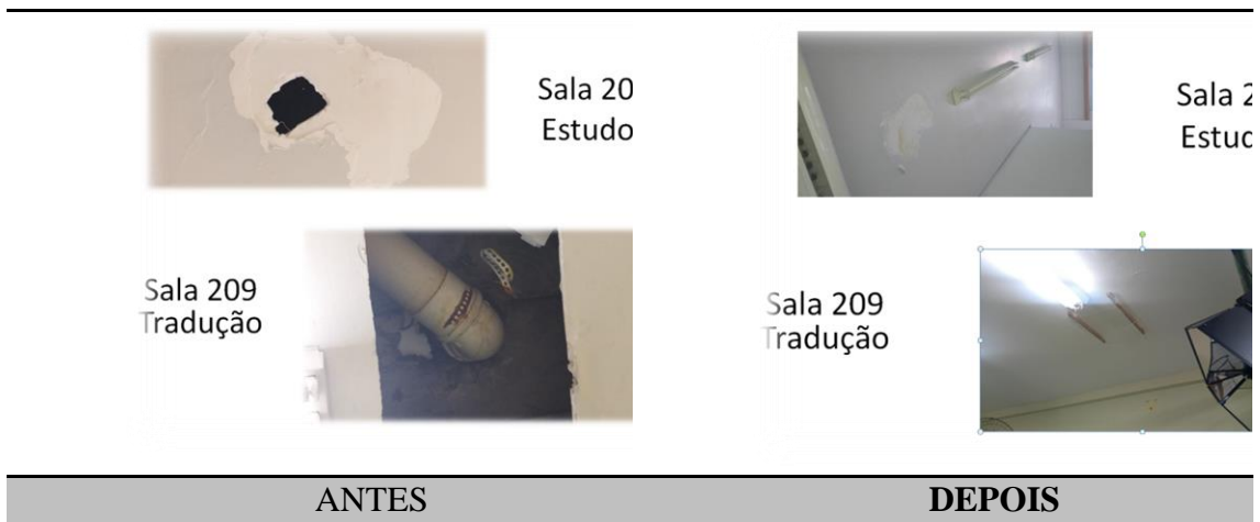
Figura 3 – Buracos no teto das salas 207 e 209, antes e depois.
