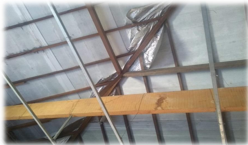
Figura 1 – Madeira a ser substituída
