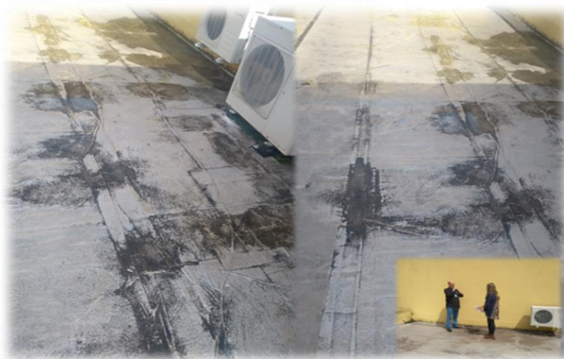
Figura 2 – Manta asfáltica que precisa ser substituída na Laje do DESU, para acabar com os vazamentos nas salas do Segundo andar.
